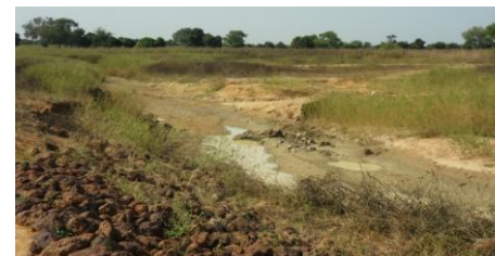
Le lit mineur en amont de la digue
