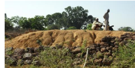
Extrémité de la digue
